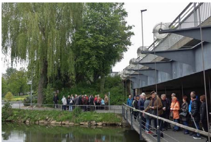
Ziehbrücke über die Vils
